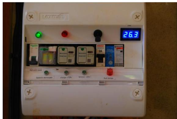
Le panneau électrique complet et le nouveau système de contrôle
